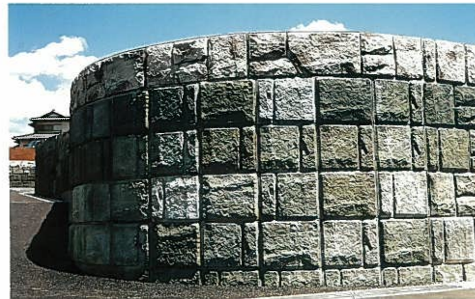
工事件名 県営(三島徳倉団地)造成工事 施工場所 静岡県 施主 三島市 擁壁高(m) 2.0~3.5 面積(m 2 ) 216.00
