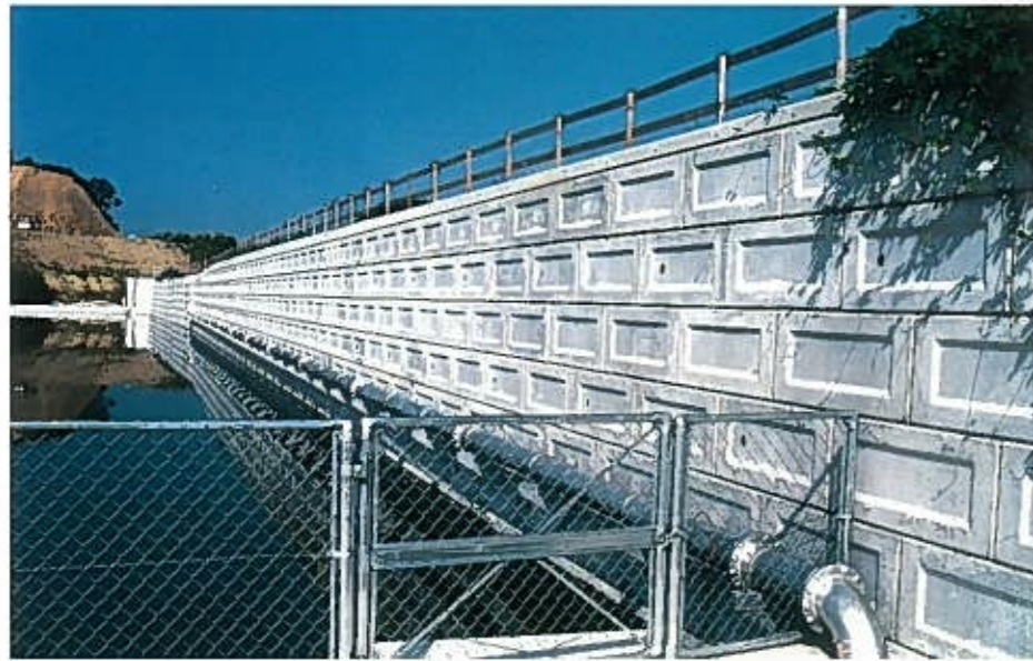
工事件名 池戸辺改良工事 施工場所 香川県 施主 建設省香川工事事務所 擁壁高(m) 6.0~7.0 面積(m 2 ) 779.40
