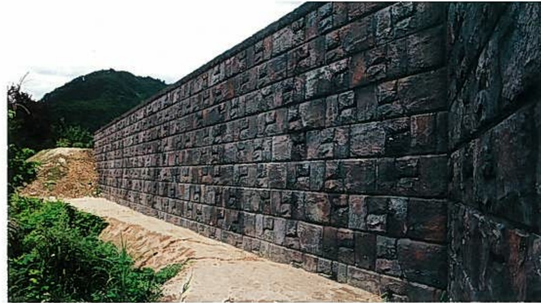
工事件名 中山間整備事業 施工場所 山形県 施主 山形県置賜平野土地改良事務所 擁壁高(m) 3.0~4.0 面積(m 2 ) 306.00
