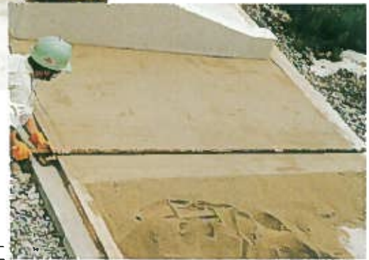
敷きモルタルの施工
