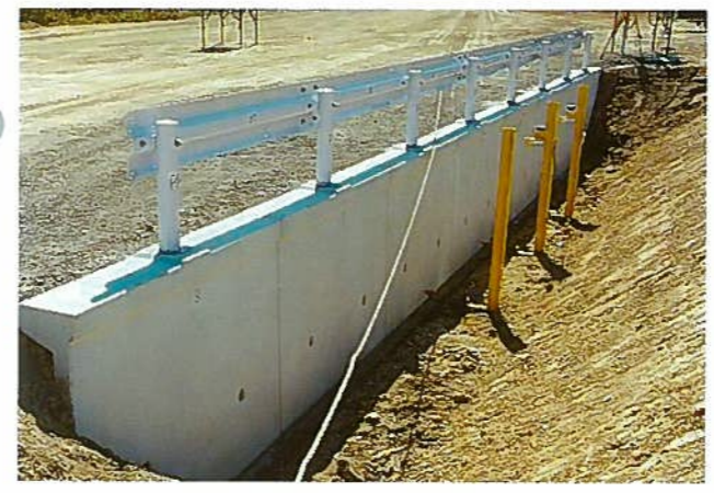
衝突実験前 (直接基礎上)
