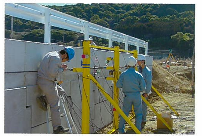
衝突実験前 (補強土壁上)
