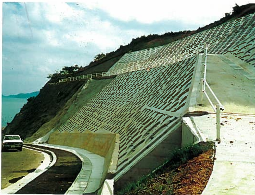
臼杵市大浜地区道路災害復旧工事(大分県市役所)
