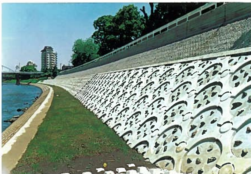
本庄特殊堤工事(建設省熊本工事事務所)
