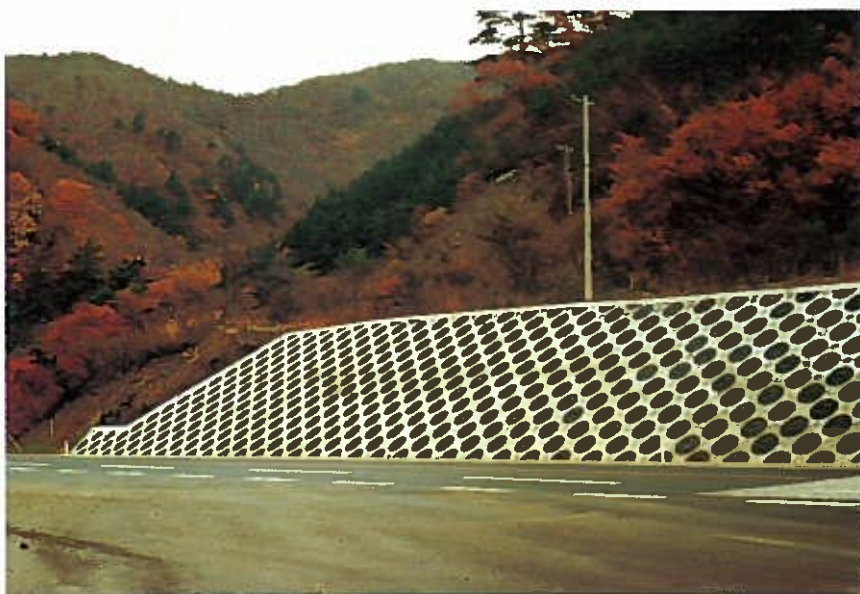
二ツ小屋地区道路法面保護(福島)
