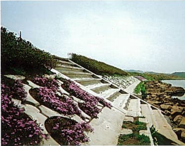
栃木県(真岡土木事務所小貝川)
